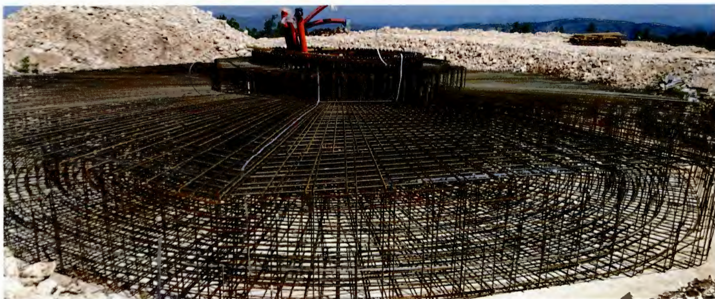
Armatura temelja z vgrajenim košem za montažo stebra vetrnega agregata. Po opaženju bo temelj pripravljen za betoniranje; foto: Arhiv HSE Invest
