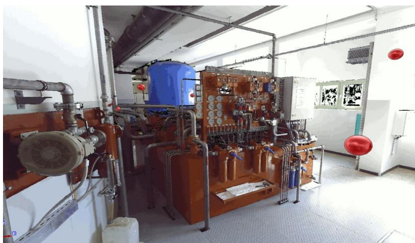
Slika 3: Primer obdelanega oblaka točk iz laserskega skeniranja
